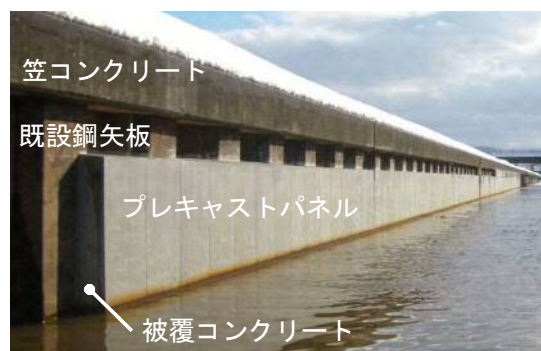
写真-3 本技術の施工事例
