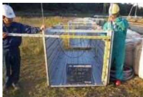
写真-6 鋼製組立式仮設水路
