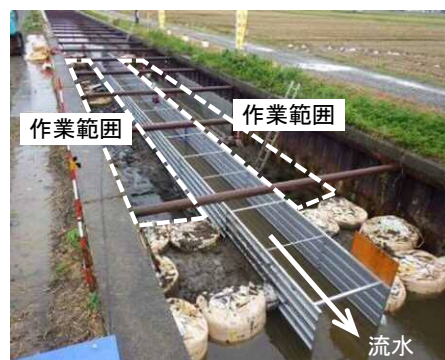
写真-8 鋼製組立式仮設水路による仮締切
