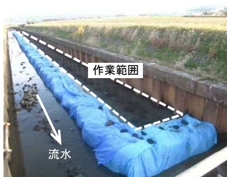
写真-7 大型土のうによる仮締切
