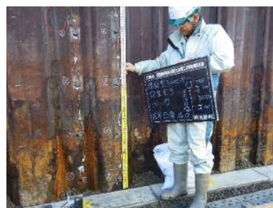
写真-25 ミニセンサ設置
