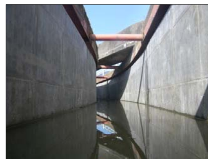
曲線部の施工
