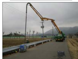
コンクリートポンプ車
