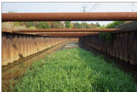
施工前（供用後46年経過）
