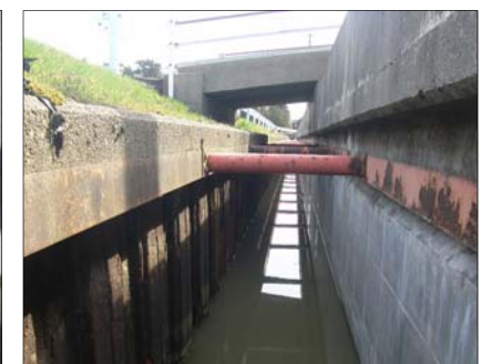
橋梁下の施工
