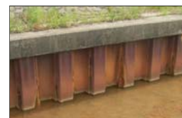
施工前（供用後15年経過）
