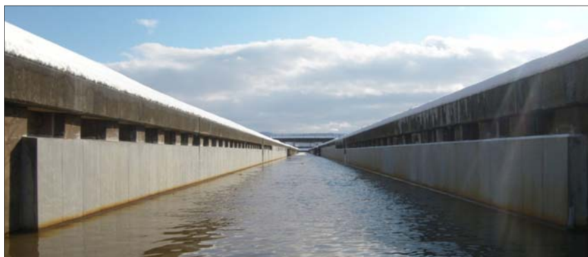
幅の広い水路の施工
